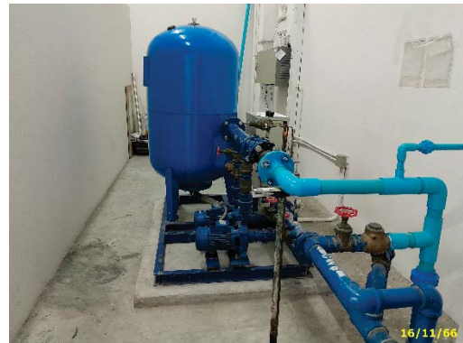
เครื่องสูบน้ำขึ้นหลังคา
